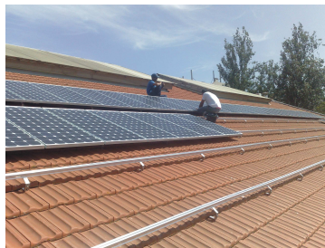
Instalação dos Painéis
